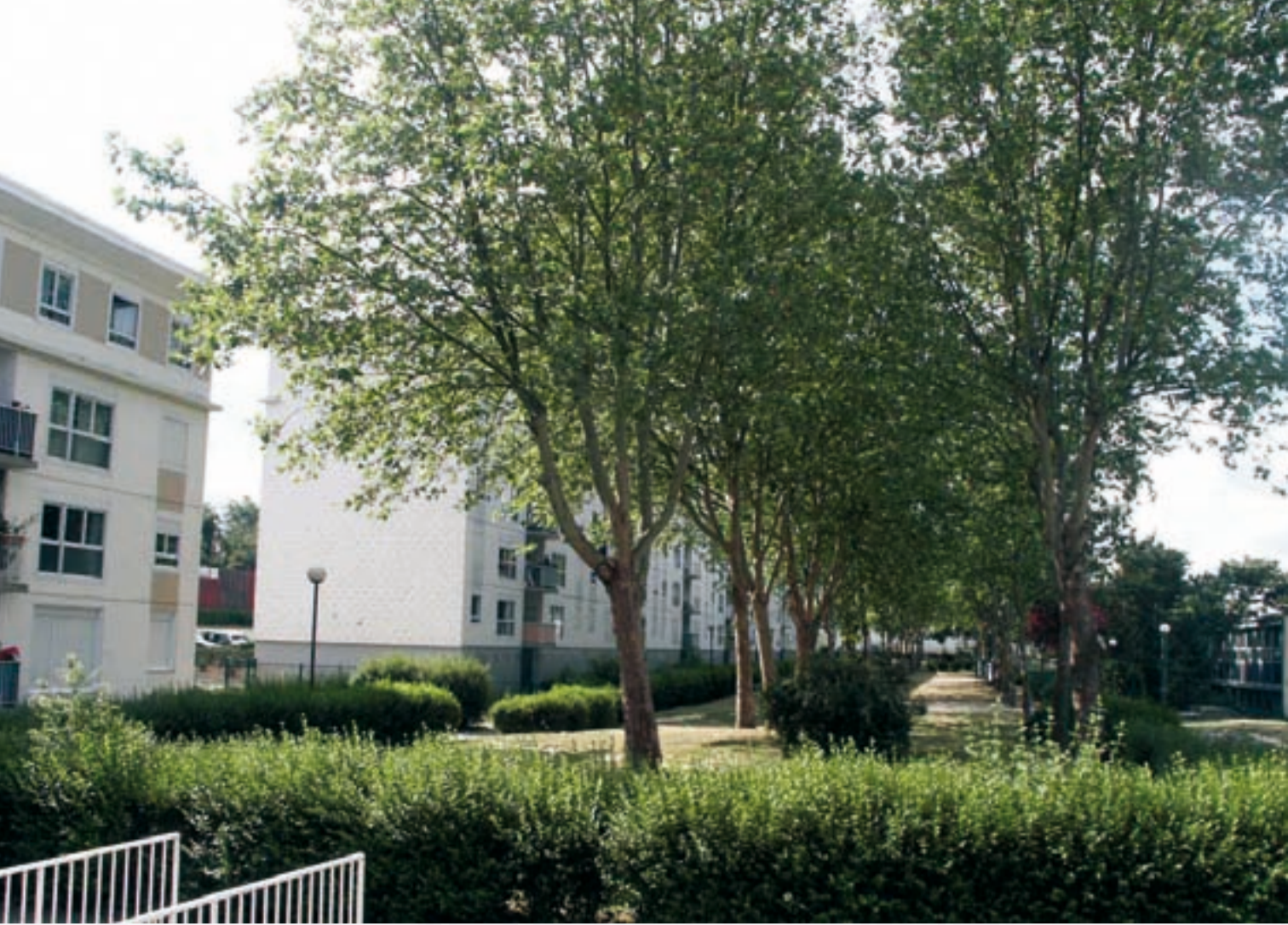
Montgeron-Vigneux-sur-Seine, immeubles réhabilités dans le cadre de l'opération de renouvellement urbain de la Prairie de l'Oly, 2000-2008. © Ville de Montgeron.
