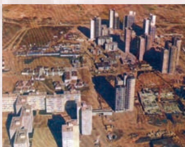
Les Ulis, vue aérienne du chantier de construction. Les tours des Hautes Bergères à droite et les Hautes Plaines à gauche, début des années 1970. Photothèque des Ulis/Ville des Ulis (91).
