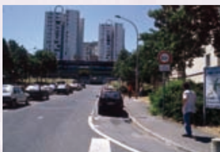
Corbeil-Essonnes, les Tarterêts, aménagement paysager après destruction partielle de la dalle, 1995. © METATTM/SIC, photo B. Suard.
