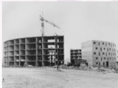
Grigny, construction d'un immeuble, vers 1968. © Archives municipales de Grigny, DR.
